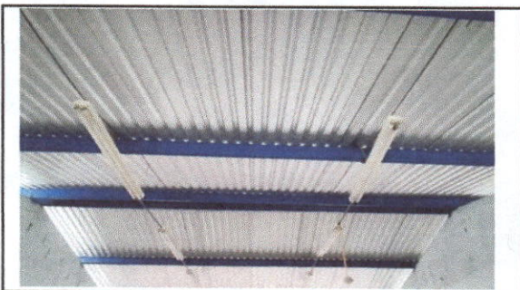
FOTO 3: Mantenimiento a estructura de soporte de metal
