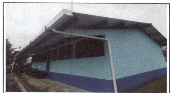
FOTO 4: Sustitución de canal de metal
