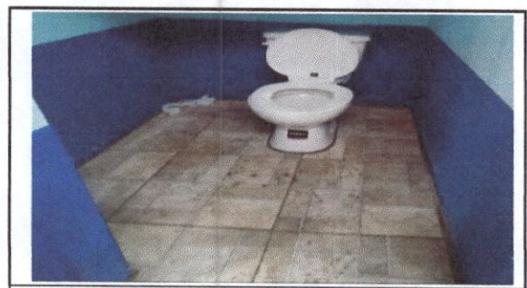
FOTO 6: Reparación de piso cerámico
